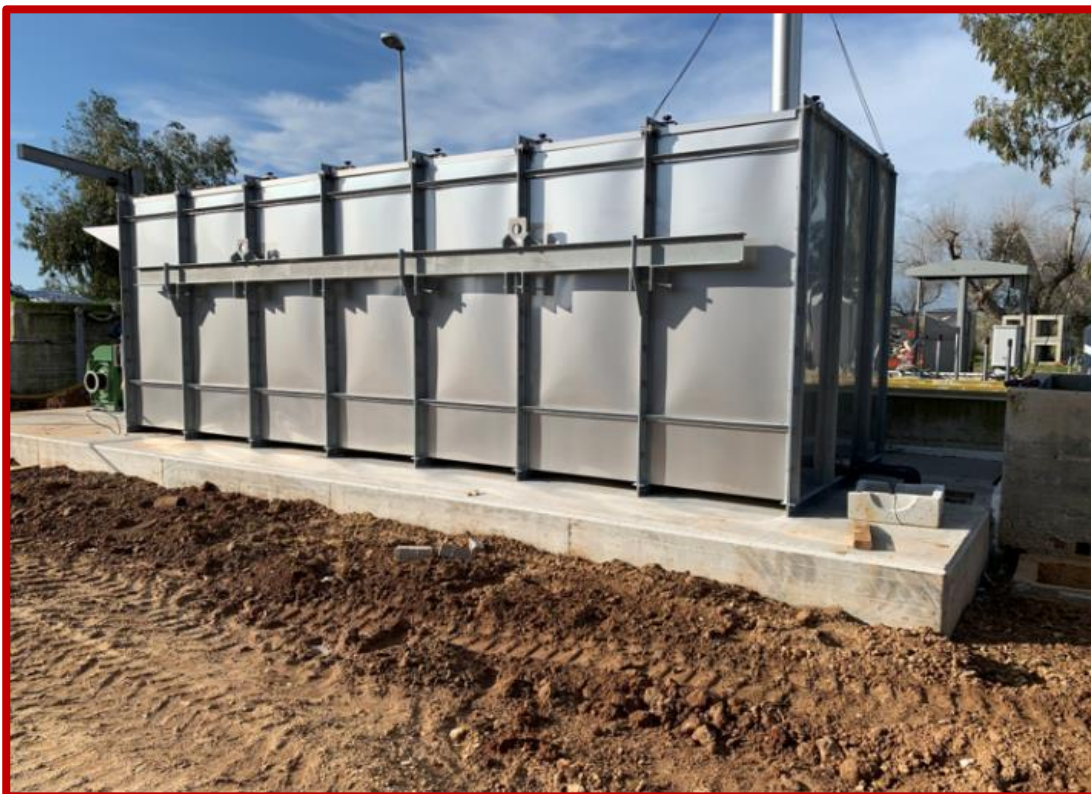
Foto 6 _Biofiltro esistente
