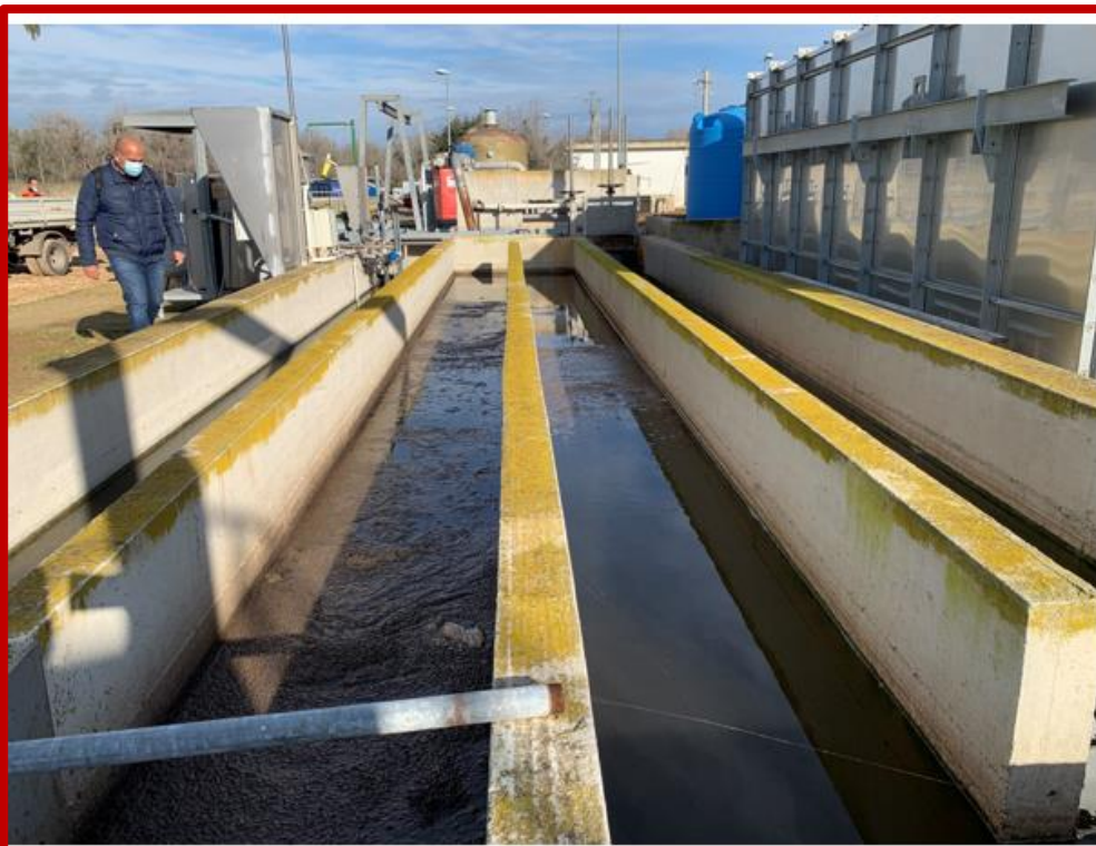
Foto 3 _Clorazione esistente
